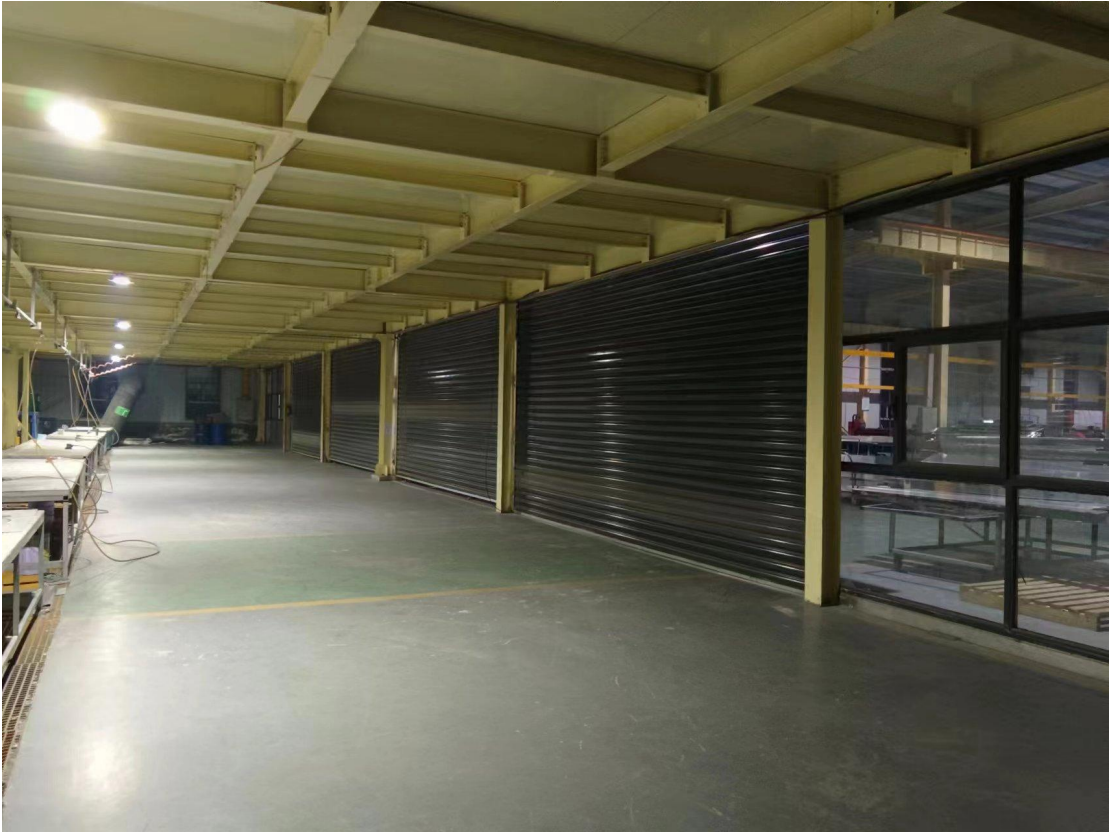
全封闭打磨间 1
