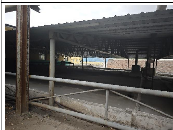
焦油池酚水池
