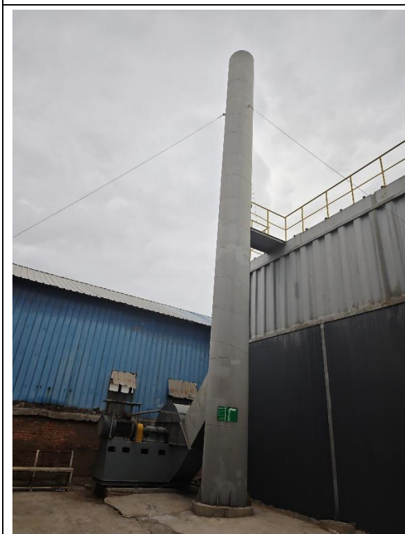
原料车间排口
