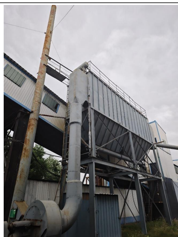
煤气站上煤排口
