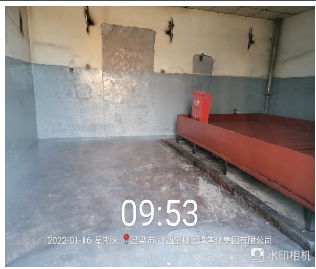
危废暂存间环氧煤沥青防腐涂料施工
