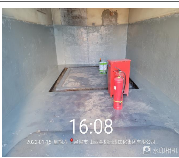
危废暂存间环氧煤沥青防腐涂料施工
