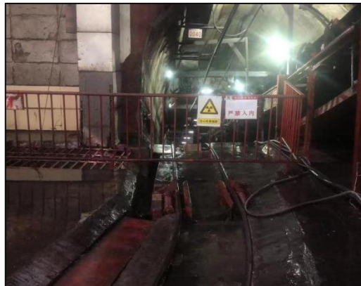
主斜井井口防护栏
