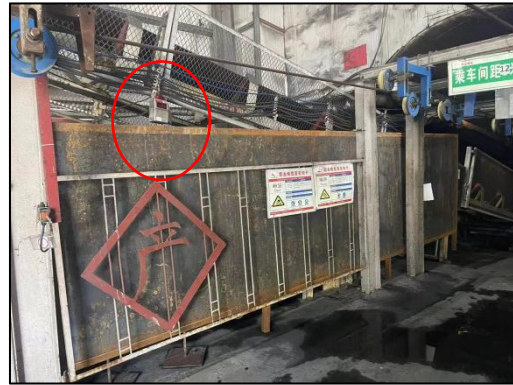
西侧防护铅板、声光报警装置
