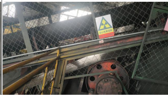
防护网外辐射防护标志牌
