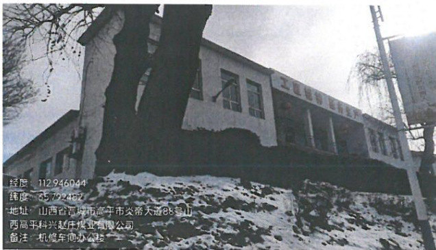
机修厂办公楼
