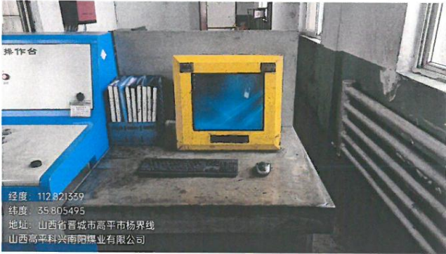
控制室操作位
