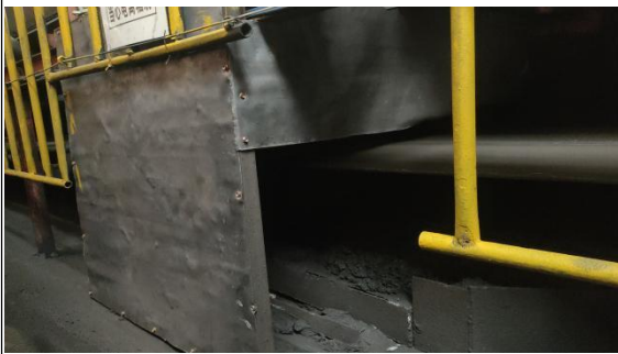
南侧钢板+铅板防护
