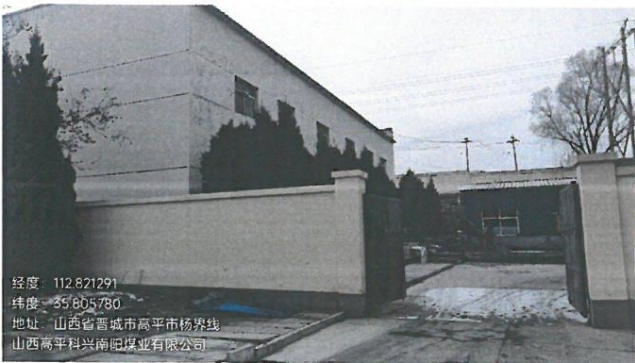
矿井水处理站
