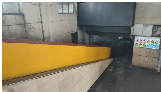
北侧钢板防护
