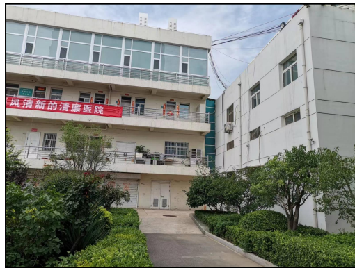
项目东南侧车队辅助楼及配电楼
