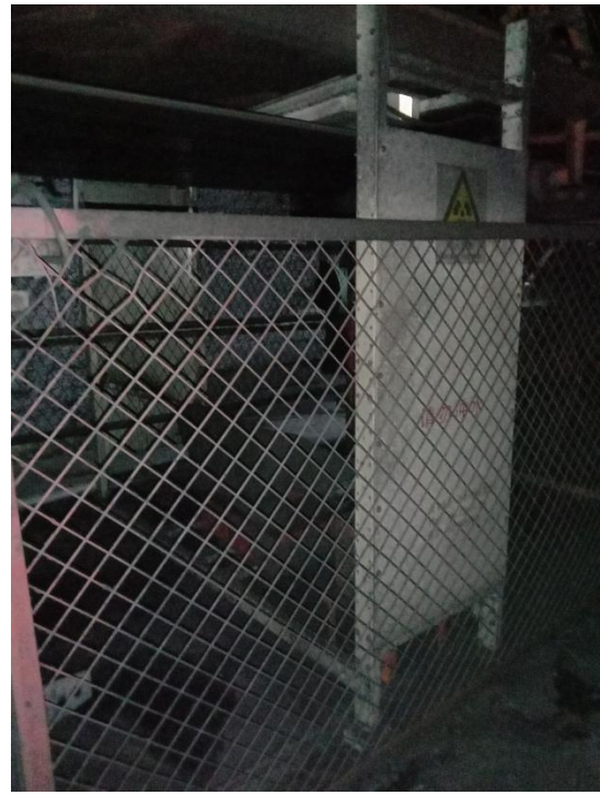
南翼三部无损检测装置工作状态指示灯
