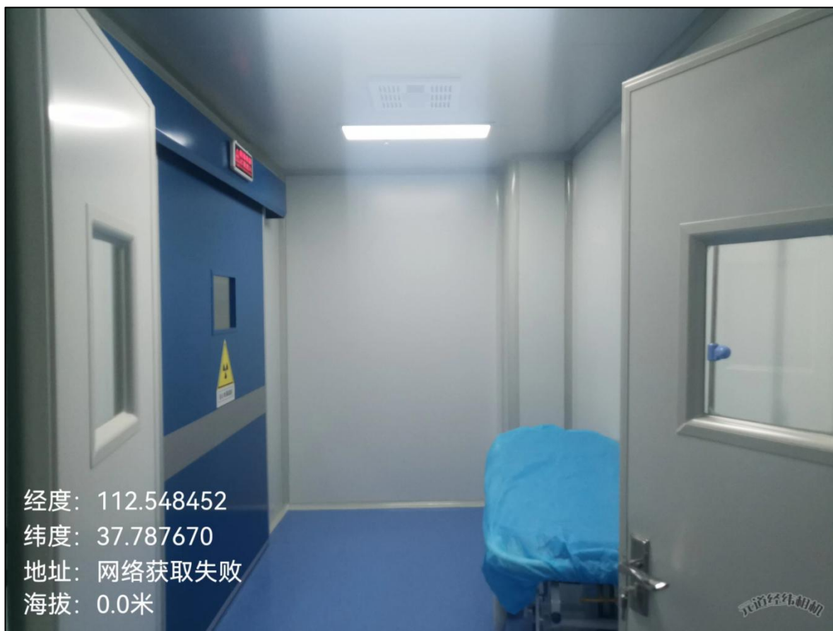
血管造影机房防护门、电离辐射标志、工作状态指示灯
