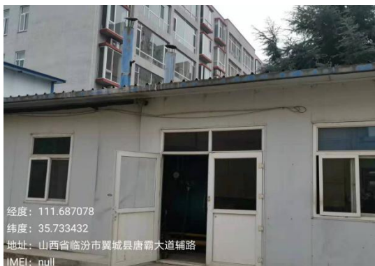
消毒锅炉排气筒
