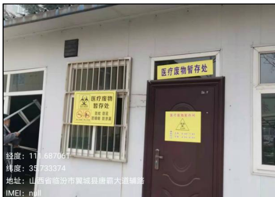
医疗废物暂存间
