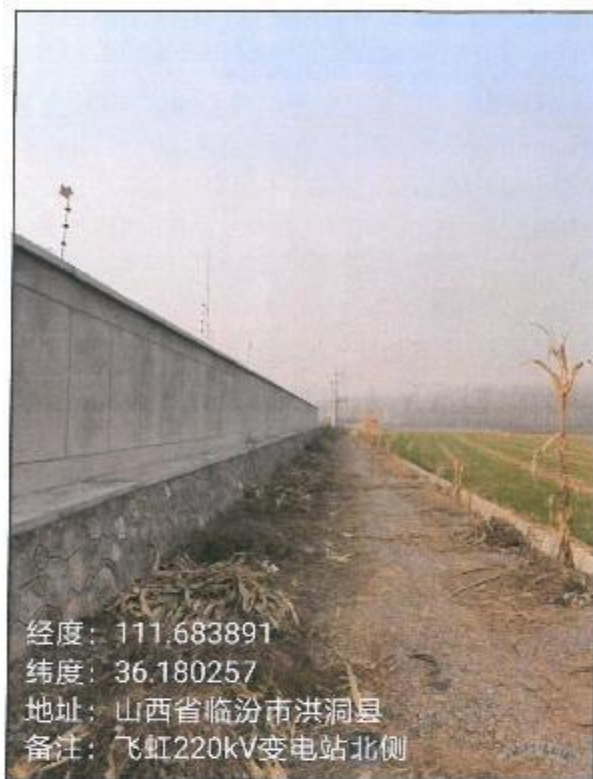
飞虹 220kV 变电站北围墙外
