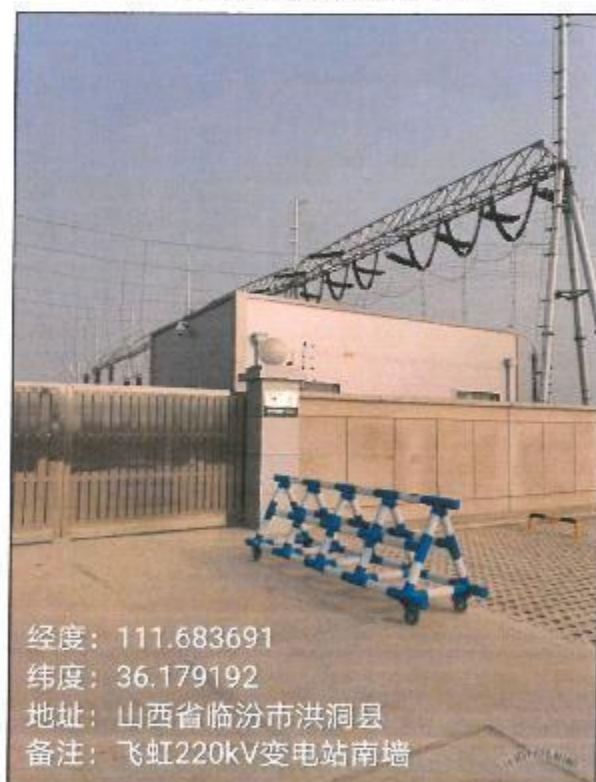
飞虹 220kV 变电站南围墙外
