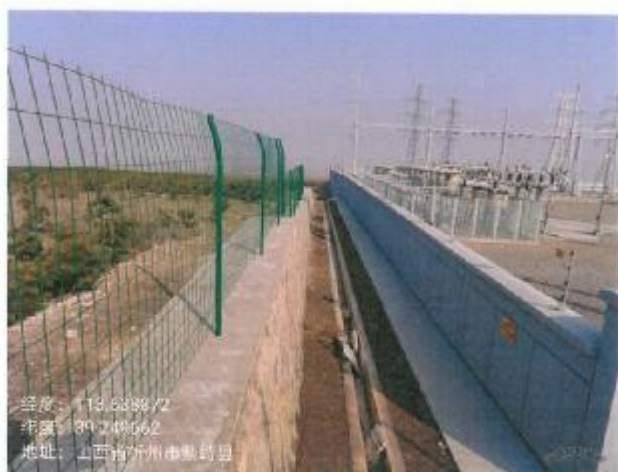
淖源 220kV 变电站西侧
