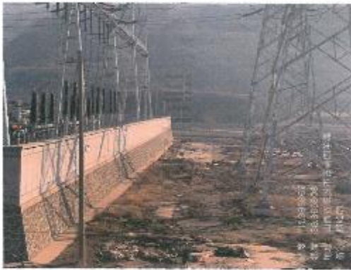
相如 220kV 变电站南侧
