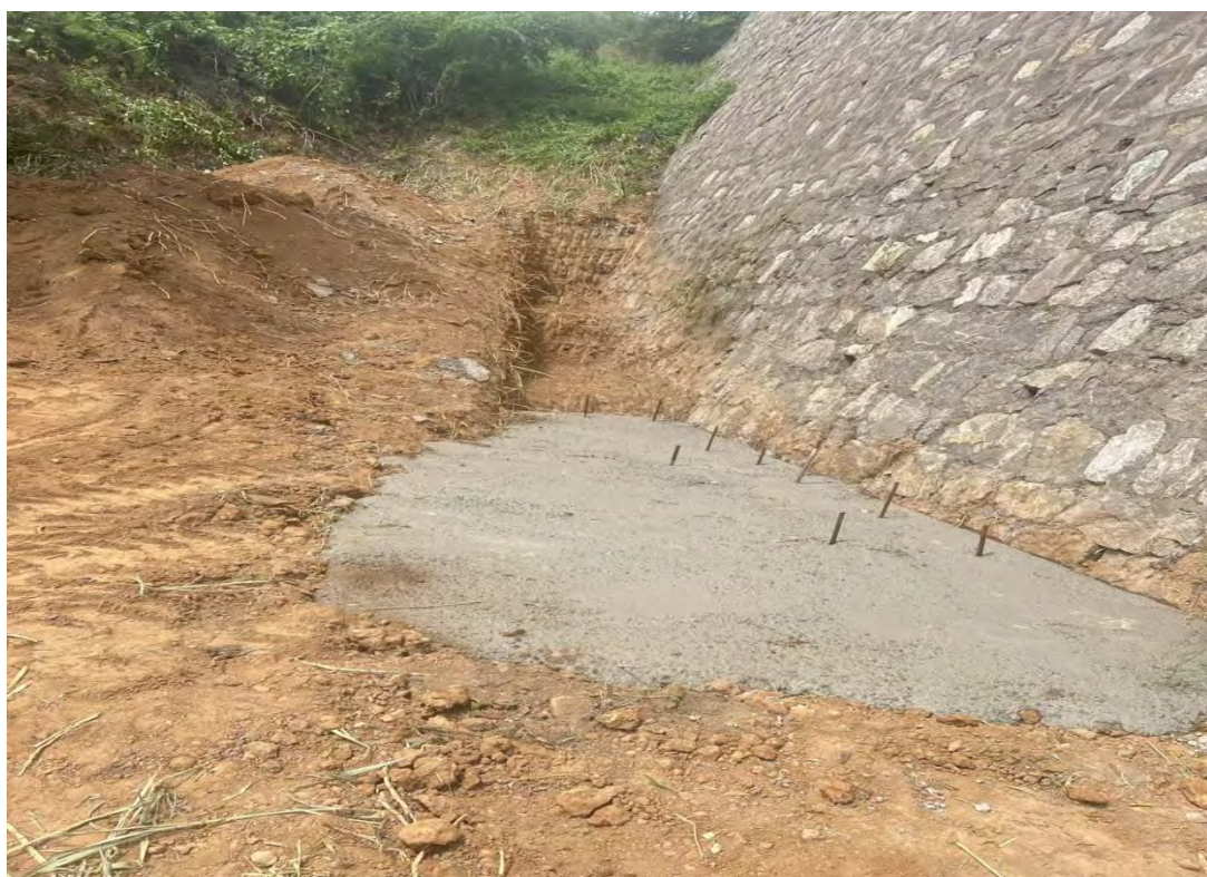
挡矸坝底部加固
