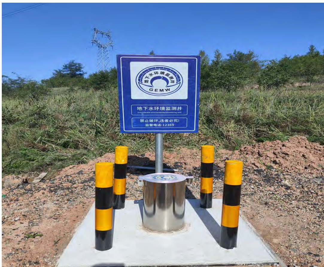
地下水监测井
