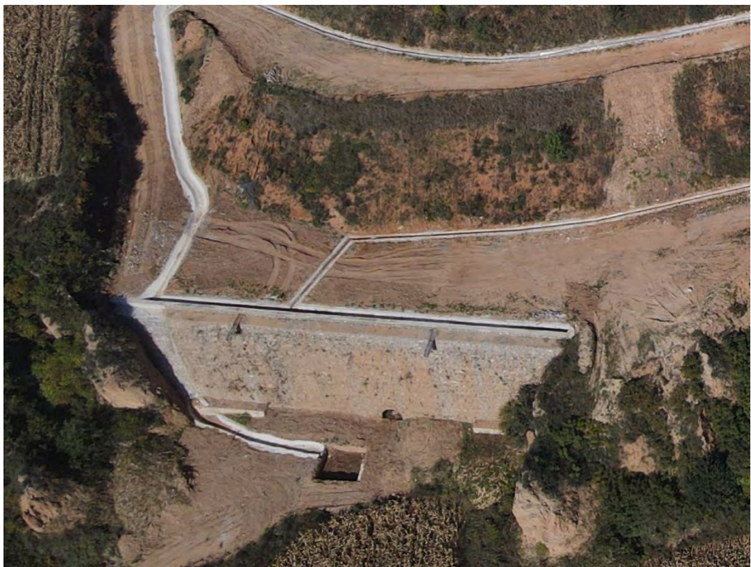
下游截洪沟及消力池
