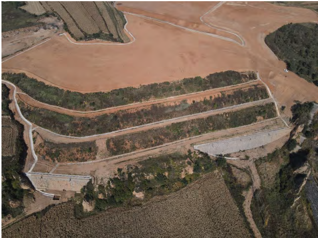
马道护坡、排水沟及挡矸坝
