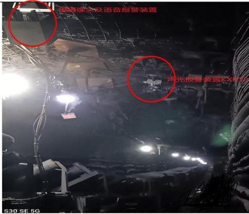
视频监控装置、声光报警装置
