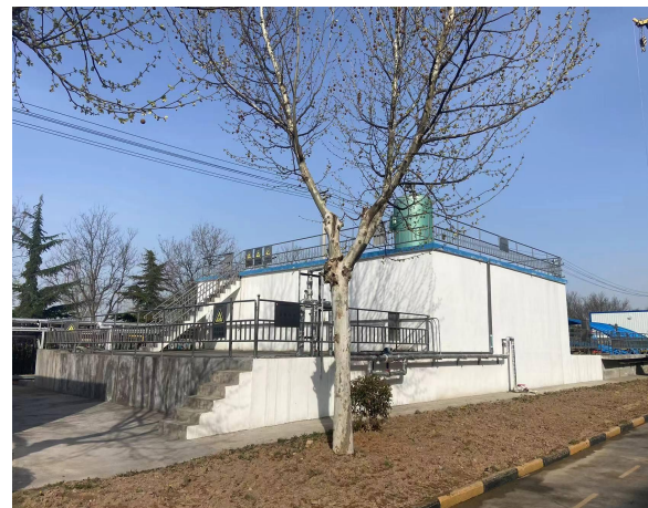
厂区污水处理站现状
