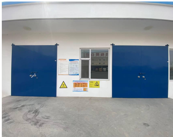
危废贮存库现状
