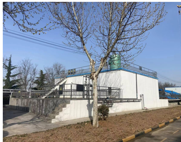
厂区污水处理站现状
