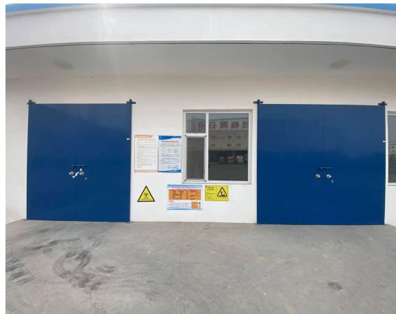
危废贮存库现状
