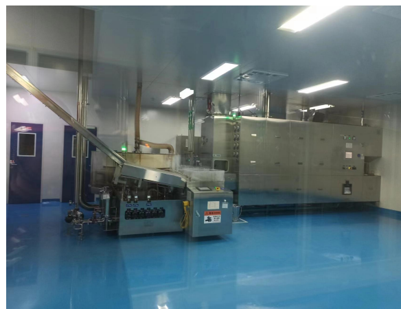
301 车间内部现状 (1)
