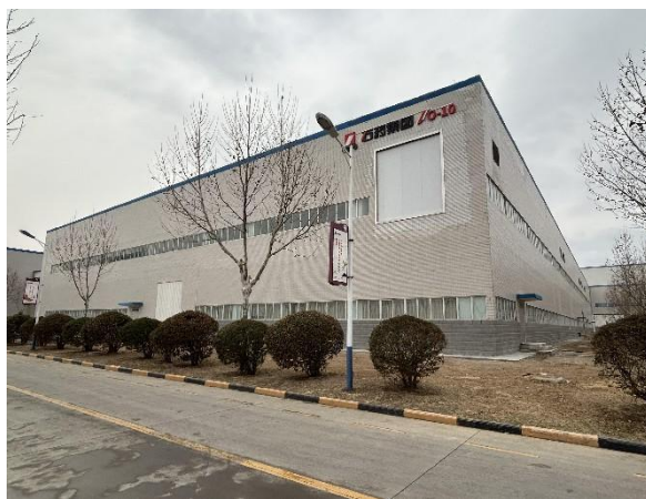
301 车间外部现状
